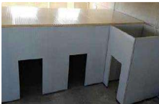
Figura 23: Paneles sándwich de cámaras frigoríficas.
