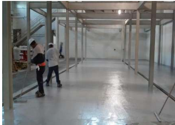
Figura 22: Suelo construido con resina epoxi.
